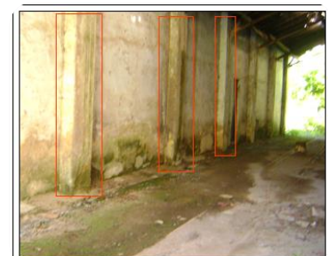
Ph 46 : les poteaux en brique
