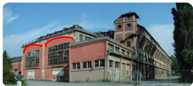
Ph 27: vue sur la façade NORD de la fonderie
