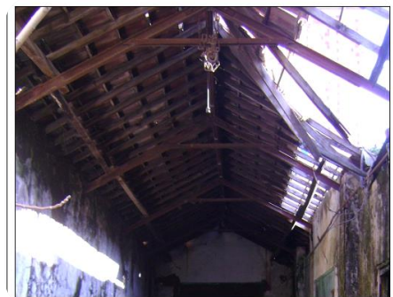
Ph 44 : la charpente mixte (bois et métal)
