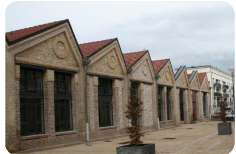
Photo12 : vue sur les sheds
