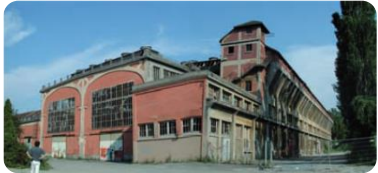
Ph28 : vue sur la façade NORD
