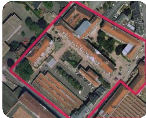
Photo8 : vue aérien de quartier BLIN et BLIN
