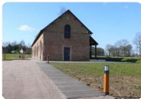
Photo 01 : Vue Sur L'ancienne Grange
