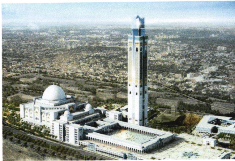
Figure. 4.4 : vue sur l'ensemble de l'édifice (Source : Google images)
