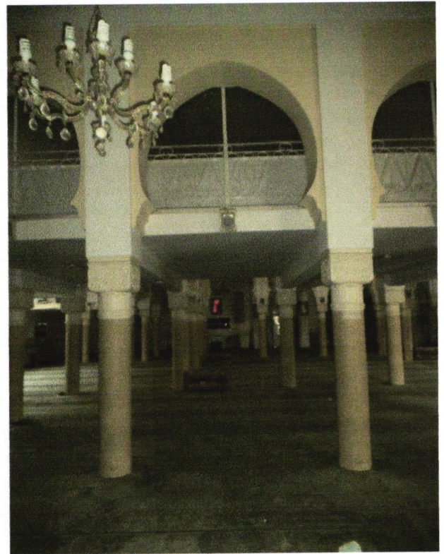
Figure. 3.65 : Arc outre passée brisée au niveau de la salle de prière (Source : Auteur)
