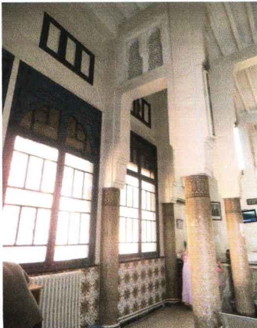
Figure. 3.38 : Vue sur les colonnes de la grande salle (Source : Auteur)
