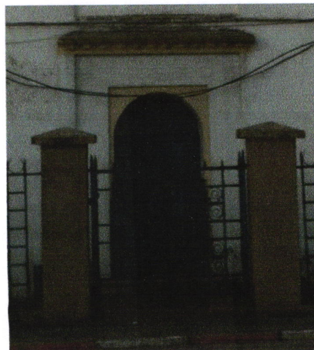
Figure. 3.42 : porte du logement de fonction coiffé en arc outre passé (Source : Auteur)
