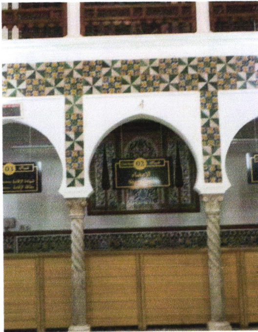
Figure. 3.24 : Arc outre passée brisée dans la galerie du patio.(Source : Auteur)
