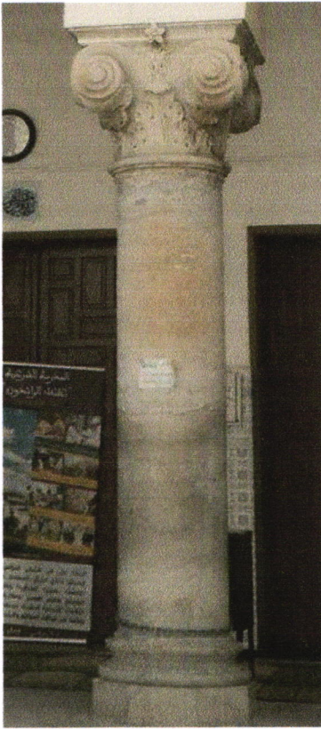
Figure. 3.70 : Grande colonne a fut cylindrique en marbre (Source : Auteur)
