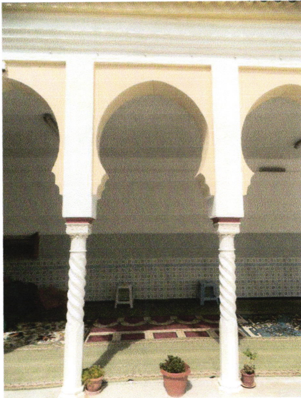
Figure. 3.64 : Arc outre passée brisée au niveau de la galerie (Source : Auteur)
