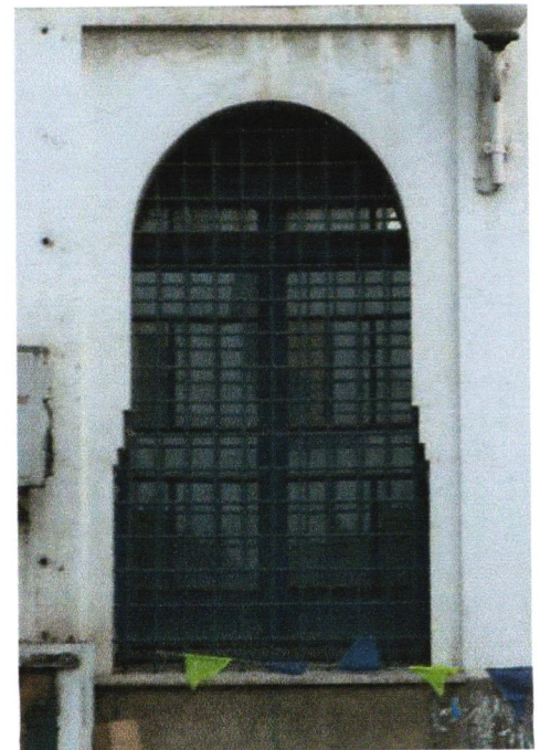
Figure. 3.47 : fenêtres en arc outrepassé (Source : Auteur)
