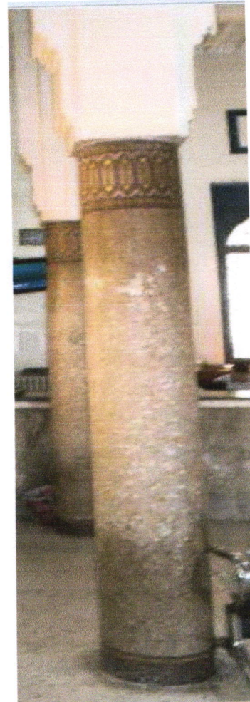
Figure. 3.52 : colonne à fut cylindrique (Source : Auteur)
