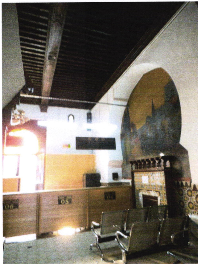
Figure. 3.17 : Vue sur la salle d'attente. (Source : Auteur)
