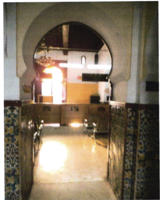
Figure. 3.25 : Arc outre passée brisée employé dans les portes intérieures. (Source : Auteur)
