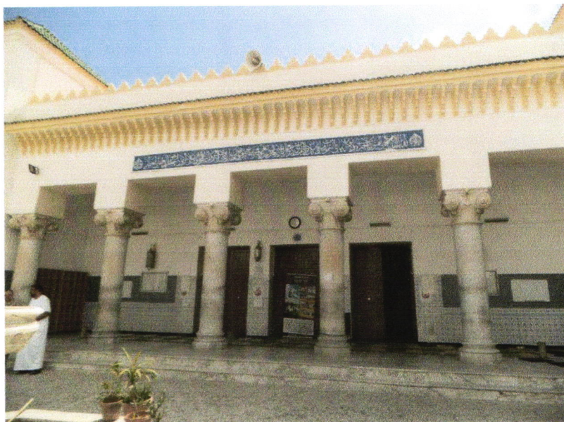
Figure. 3.58 : L'entrée à la salle de prière (source :Auteur )
