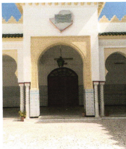
Figure. 3.62 : Arc plein cintre au niveau de la porte (Source : Auteur)
