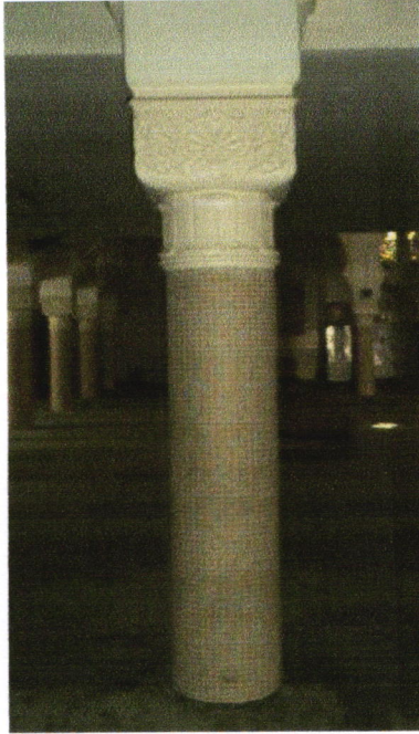
Figure. 3.66 : Colonne a fut cylindrique (Source : Auteur)
