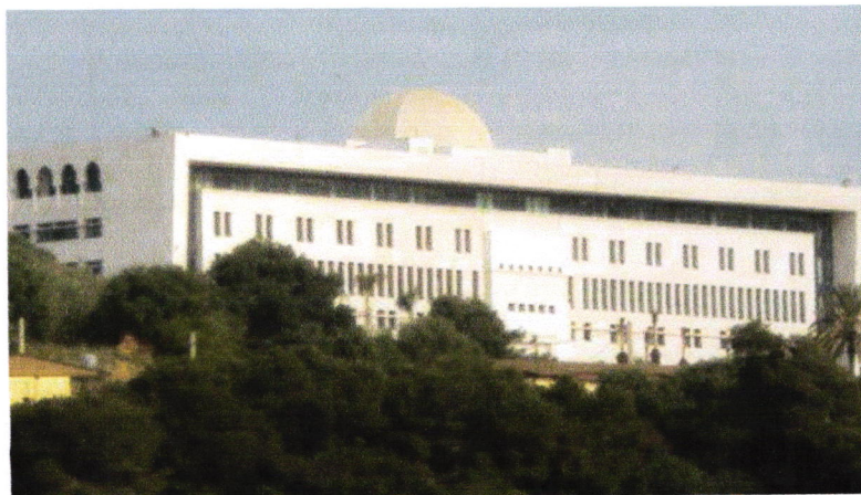
Figure. 4.3 : vue sur l'ensemble de l'édifice (Source : www.mercure-eng.fr )
