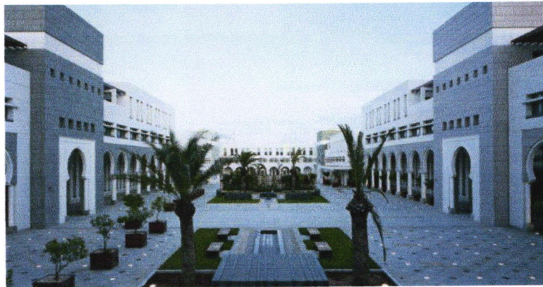
Figure. 4.2 : vue sur la cour centrale 2 (Source : www.mercure-eng.fr )
