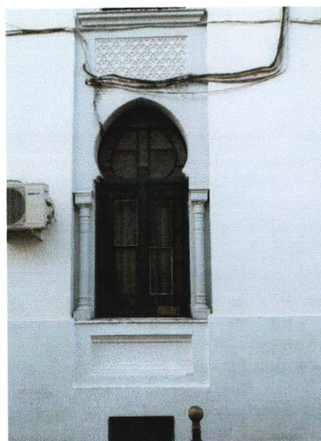
Figure. 3.23 : Fenêtres en arc outre passée brisée sur deux colonnettes. (Source : Auteur)
