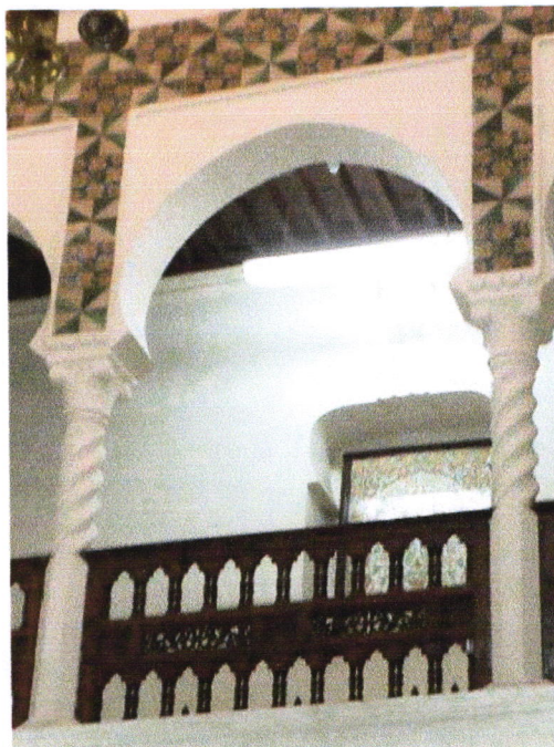
Figure. 3.24 : Arc outre passée brisée dans la galerie du patio.(Source : Auteur)
