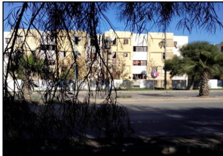
Habitat collectif R+3 Moyen état Construction légale Béton armé Construit en 1986
