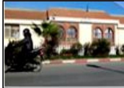
CEM R+1 moyen état Construction légale Béton armé Construit en 1990
