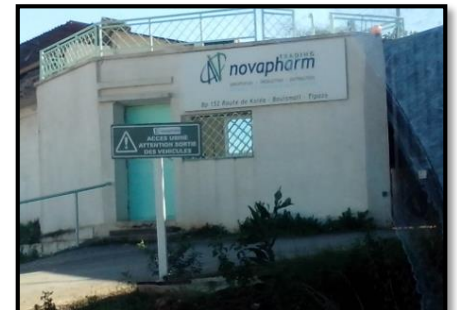
Usine Novapharm R+2 Bon état Construction légale Béton armé Construit en 1997
