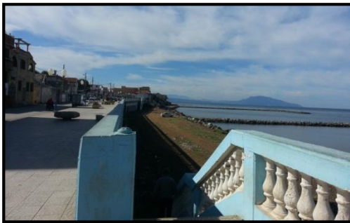
Fig9.2 : Boulevard front de mer
