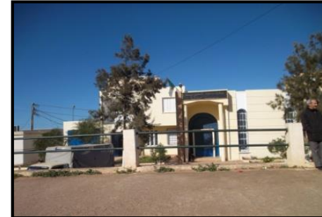
Agence postale R+1 Bon état Construction légale Béton armé Construit en 2004
