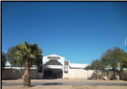
CFPA R+1 moyen état Construction légale Béton armé Construit en 1982
