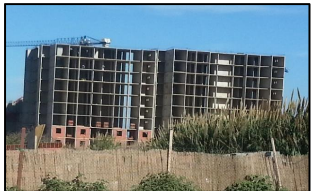
Fig25.2 : Habitat post colonial: Utilisation du béton armé et la brique
