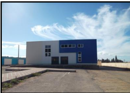
Marché RDC BON état Construction illicite Charpente métallique Construit en 2013
