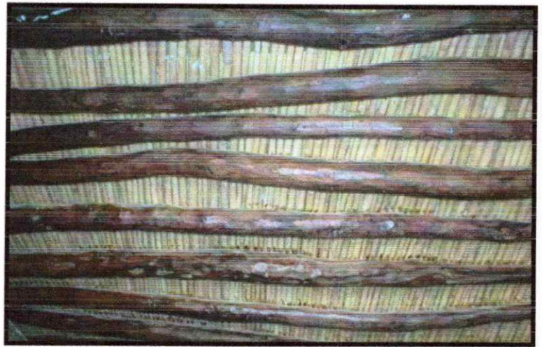
Fig.28 : Plancher sur rondins de thuya et branchages
