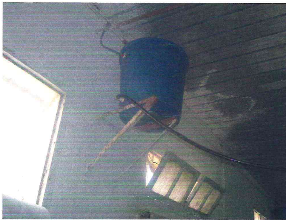
PHOTO (10) : Réservoir interne pour la conservation d'eau (ITELV BABA ALI)
