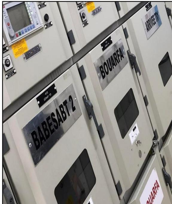
Figure 1.12: Cellules d'un poste HTB/HTA
