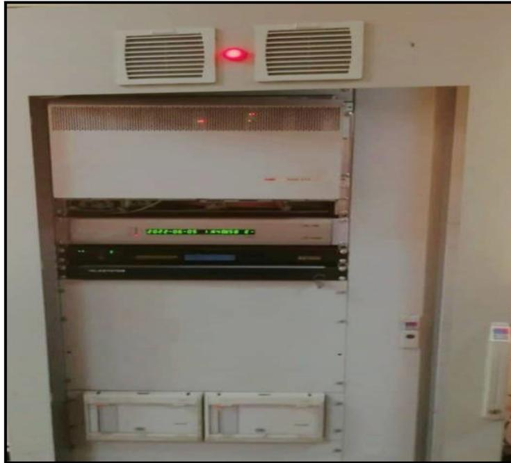
Figure 2.35 : FOX 115 ABB Fibre optique
