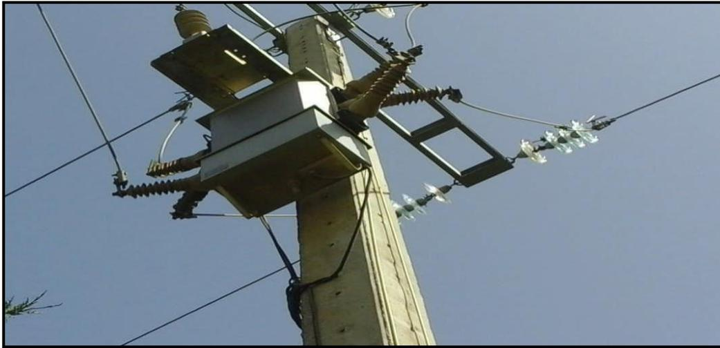
**Figure 2.19:** Interrupteur aérien automatisé
