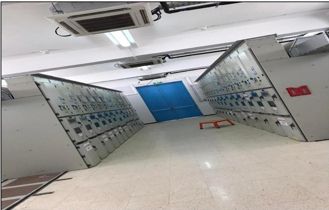
**Figure 1.10:** Les cellules d'un poste électrique
