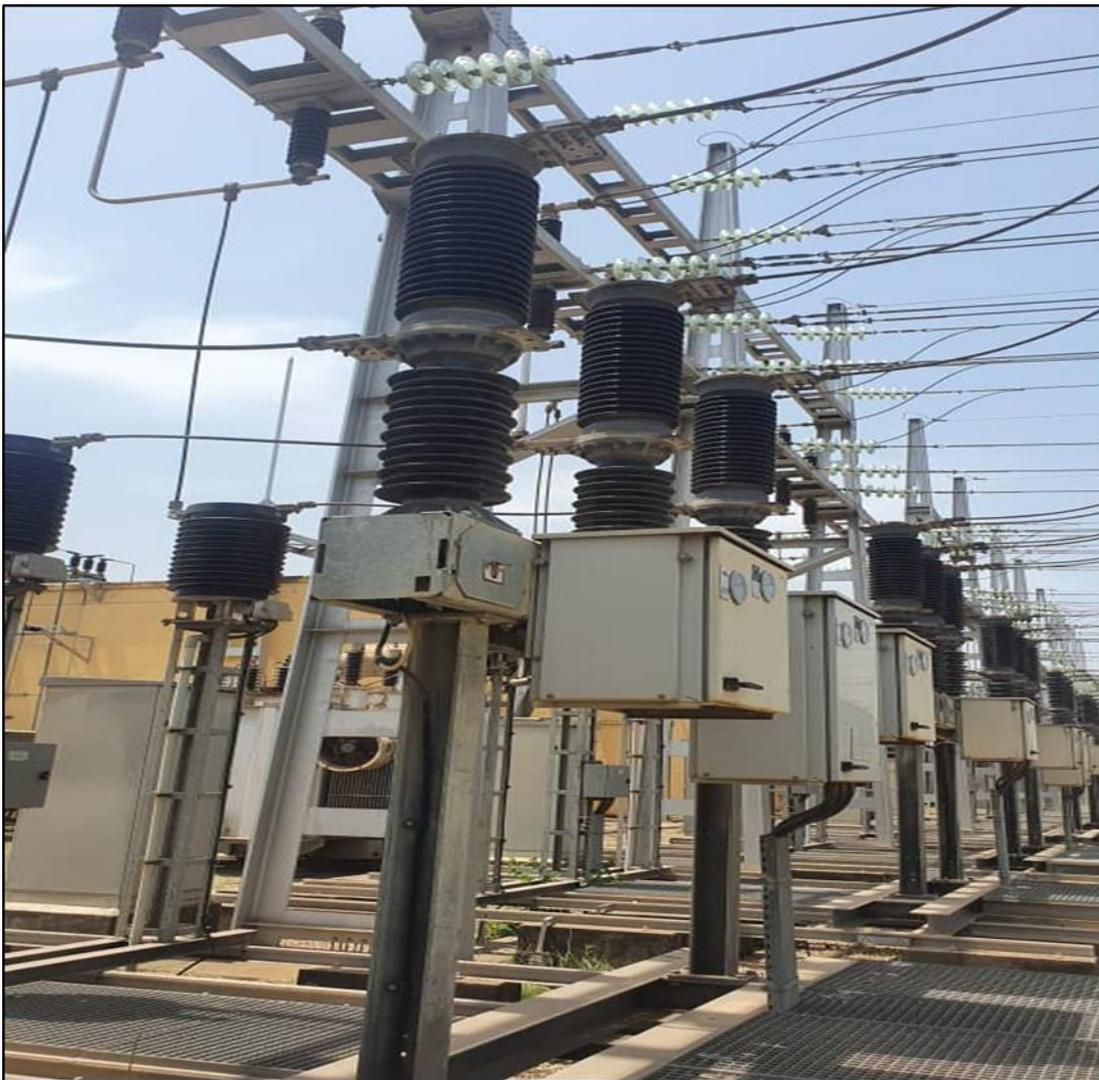
**Figure 1.21:** Disjoncteur à haute tension.
