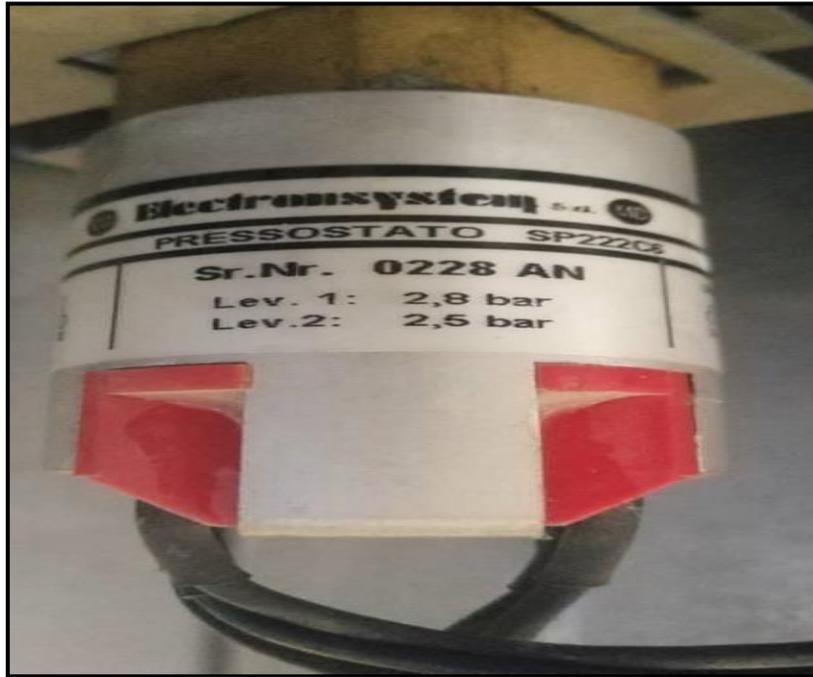
**Figure 2.17:** Pressostat du gaz SF6
