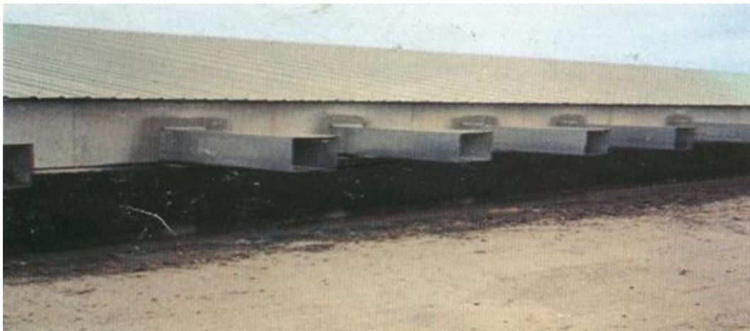
Figure 03 : Ventilation dynamique ( Bisimwa, 2004)
