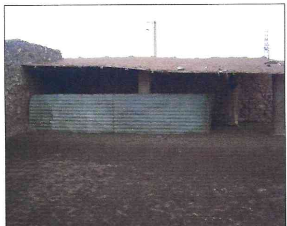
Figure n° 28: Surfaces séparées à l'intérieur des bergeries.
