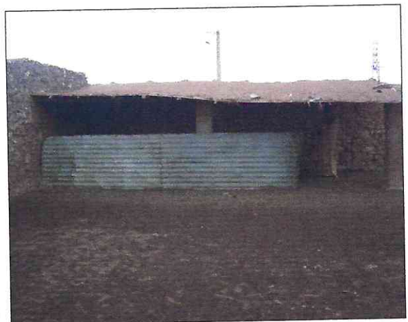
Figure n° 28: Surfaces séparées à l'intérieur des bergeries.
