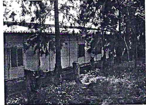
Bâtiment cunicole de l'ITMA (Boukhalfa)
