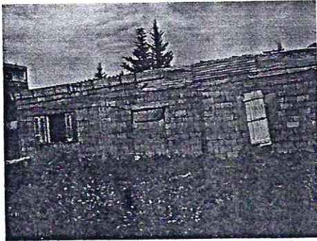
Bâtiment d'élevage du lapin (Fréha)
