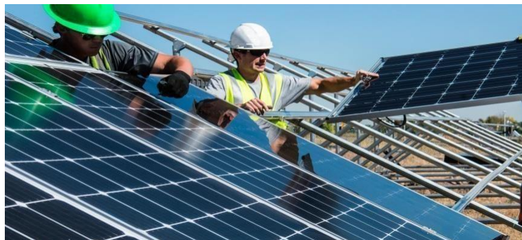
Figure 2.2) : des techniciens de PV
