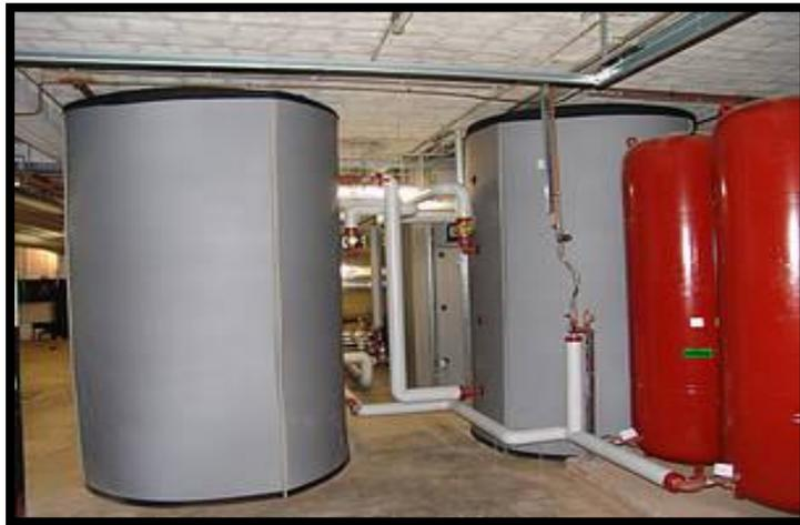
**Fig.15.cuves de stockage**
