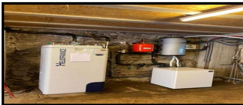
**Fig.12.Système à éléments séparés - auto-vidangeables**
