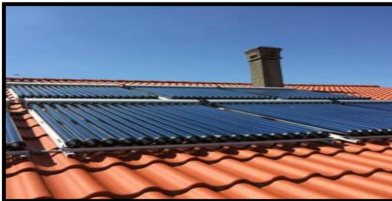
Fig.10. Capteur tubulaire
