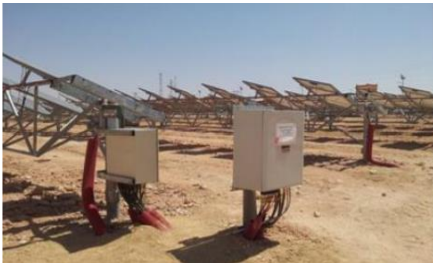
Figure2.3. les boites de raccordements [10]
