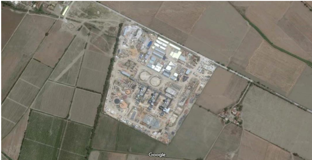
Figure 3-1 : Vue aérienne de la centrale de Boufarik
