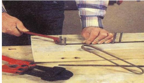
Figure I.5 : Façonnage du fer.[8]
