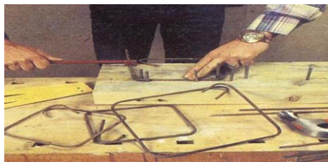
Figure I.7: Pliage du fer en forme de carré terminé.[8]
