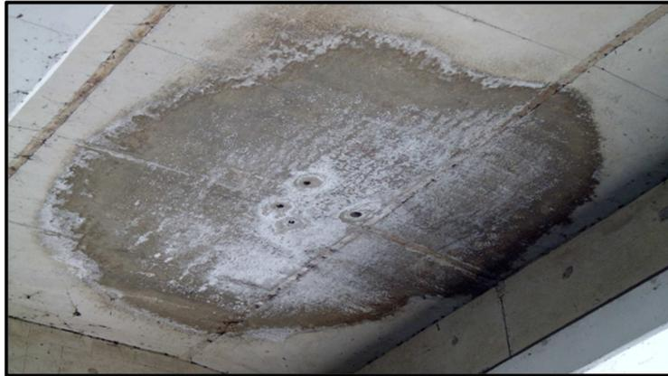
Figure 3-3. Illustration d'une tache due aux dégradations [31].
