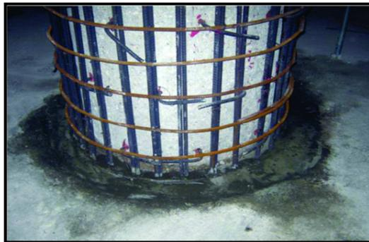
Figure 1-20. Renforcement par chemisage [16].
