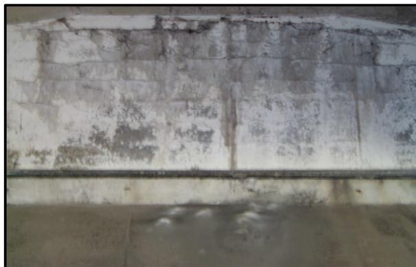
Figure 3-4. Réaction Alcalis-Granulats dans un sommet de pont [31].
