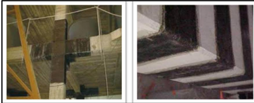
Figure 2-5. Renforcement par collage du TFC [26].
