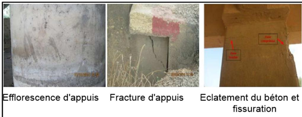
Figure 3-5. Quelques exemples des dégradations qui touchent les appuis [32].
