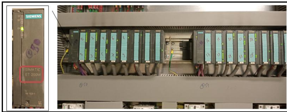
Figure 3.3 : L’ET-200M associé dans la zone cru
