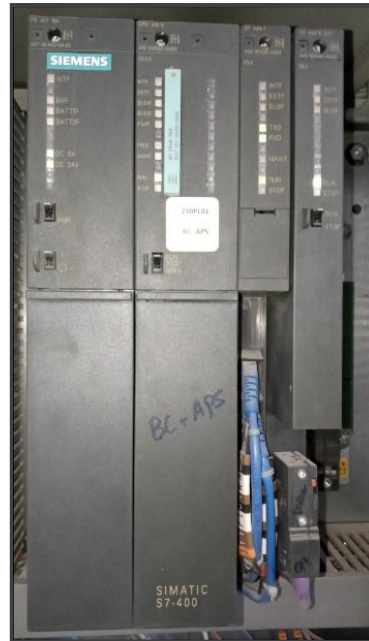
Figure 3.2 : L'automate S7-400 associé dans la zone cru
