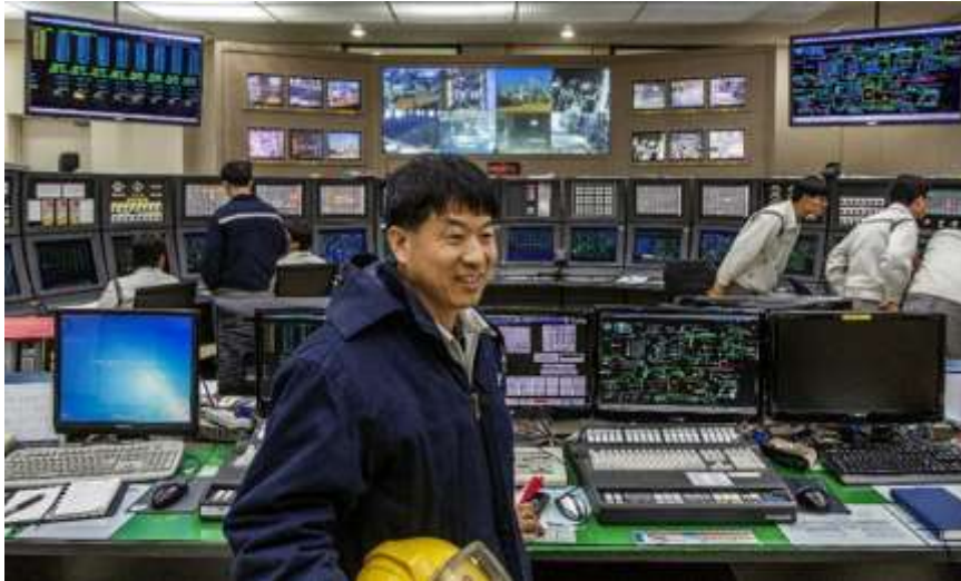
Figure II. 12: Salle de contrôle
