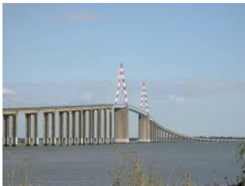
Figure 2.11:vue sur la passerelle Source : http://insitu.revues.org/
