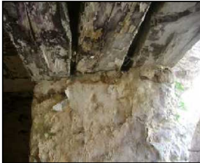
Figure II.6: Linteau en trois pièces fractionnées de bois équarris
