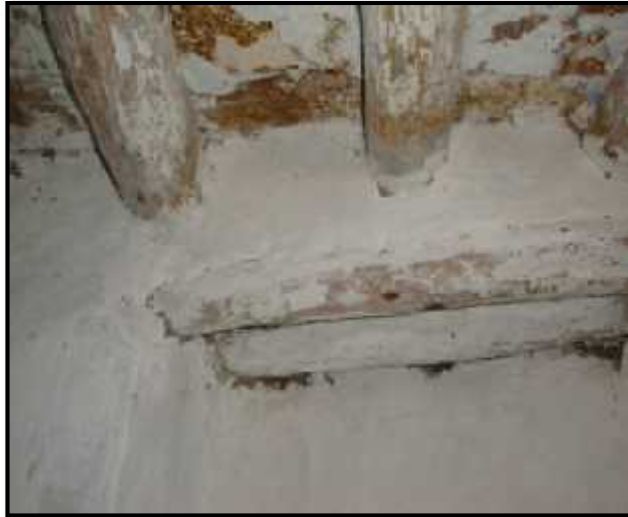
Figure II.5: Linteau fractionné (en rondins de thuya).
