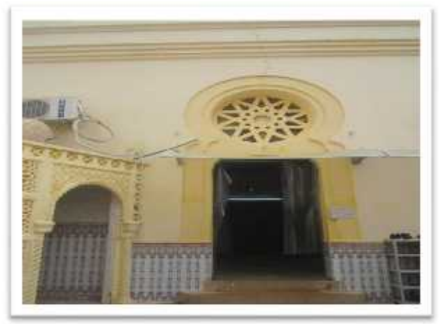
Les éléments architectoniques dans l'intérieur
