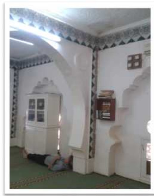
Le plâtre dans le plafond
