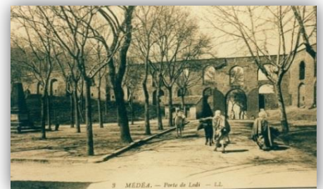
Figure III.24 l'aqueduc et la porte des arcades
