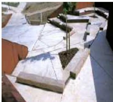
Figure 71: Système triangulaire de joints de dilatation (source: <http://fr.wikiarquitectura.com>)
