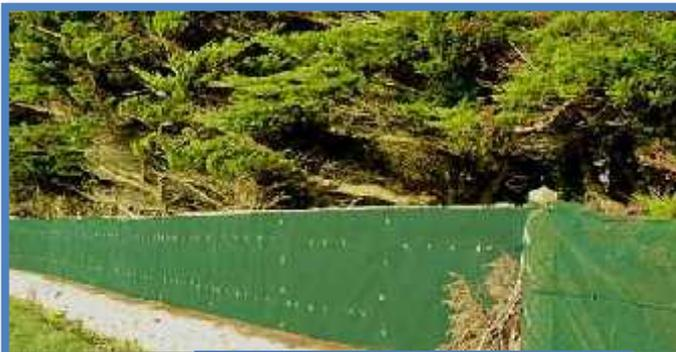
Figure 18 : Barrière Brise vent
