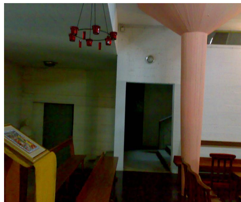
Figure 3.50 : vue intérieure de poteau champignon
