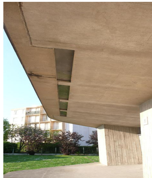
Figure 2.38: Éclairage par le sol de la salle d'assemblée. Phot. Paul Barnoud. © Atelier Cairn architectes.
