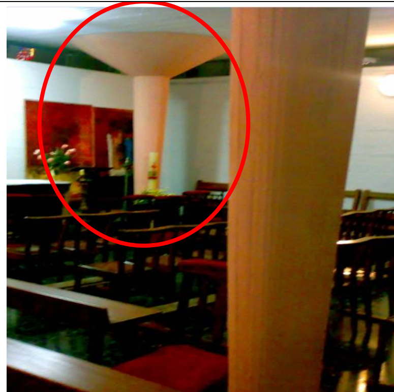
Figure 3.49 : Vue intérieure de poteau champignon
