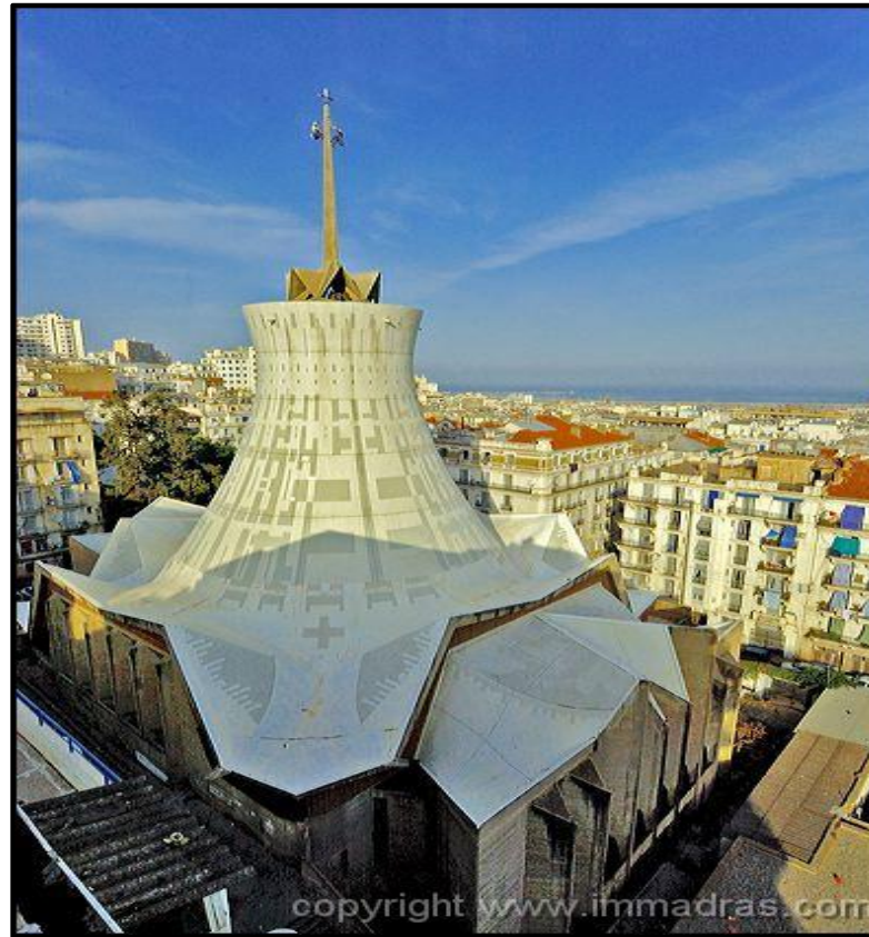
Figure 3.54 : vue extérieur de l'église
