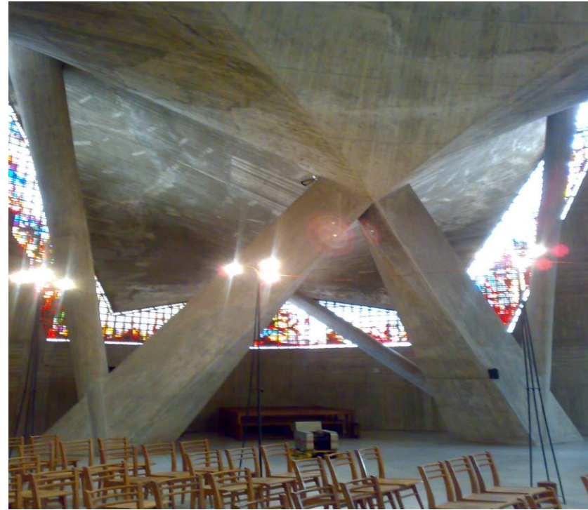
Figure 3.39 : Vue intérieur de tripode
