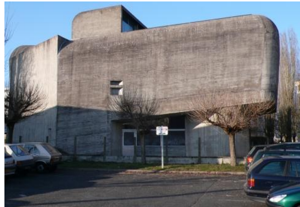
Figure 2.35: Façade de sud Phot. Paul Barnoud. © Atelier Cairn architectes.
