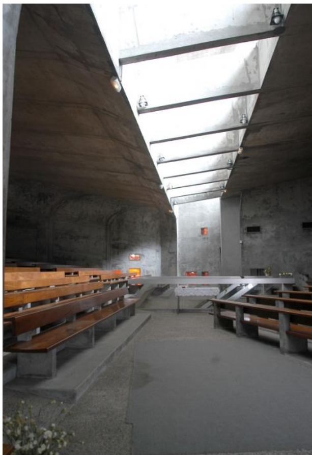
Figure 2.30: Le lanternon joue le rôle structurel de poutre transversale. Phot. Paul Barnoud © Atelier Cairn architectes.
