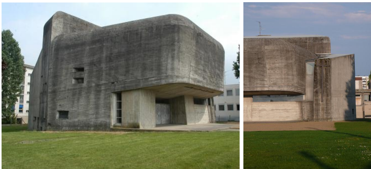
Figure 2.23 : Fente de lumière au contact entre les deux coques de béton. Phot. Paul Barnoud. © Atelier Cairn architectes
