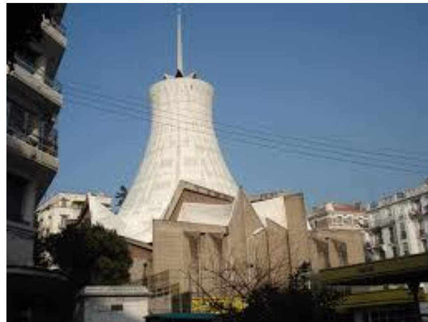
Figure 3.55 : vue extérieur de l'église
