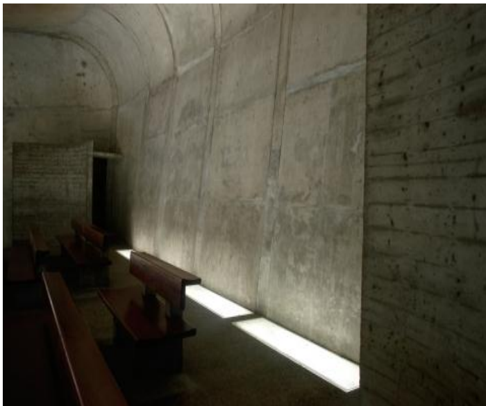
Figure 2.37: Éclairage indirect du mur ouest. Phot. Paul Barnoud. © Atelier Cairn architectes.
