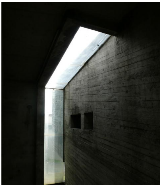
Figure 2.39: Fente de lumière au droit de l'escalier sud. Phot. Paul Barnoud. © Atelier Cairn architectes.
