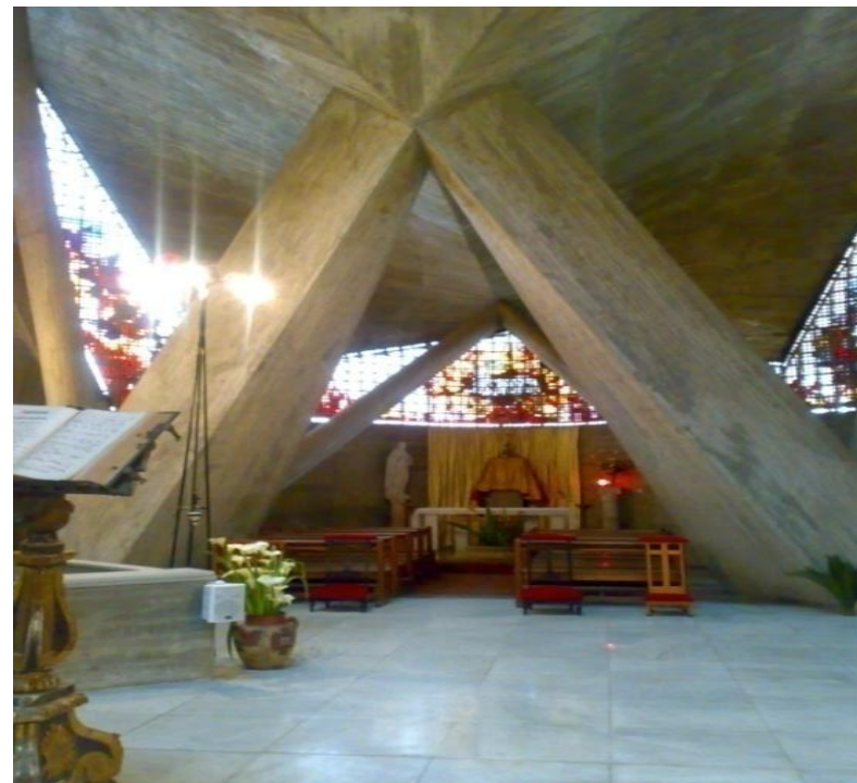
Figure 3.40: Vue intérieur de tripode
