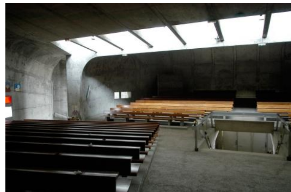
Figure 2.27: Articulation entre les deux coques. Phot. Paul Barnoud. © Atelier Cairn architectes.
