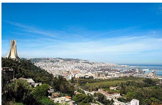
Figure 3 :vue en hauteur de la zone d'étude (source : photo prise sur site)
