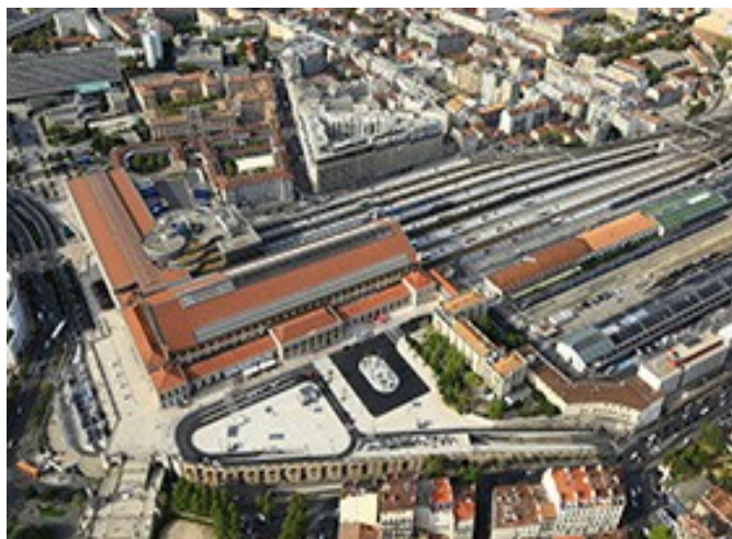
Figure 11 :la gare de Saint Charles accueille 15 million de passager par an(source: www.euromideterannée.com )
