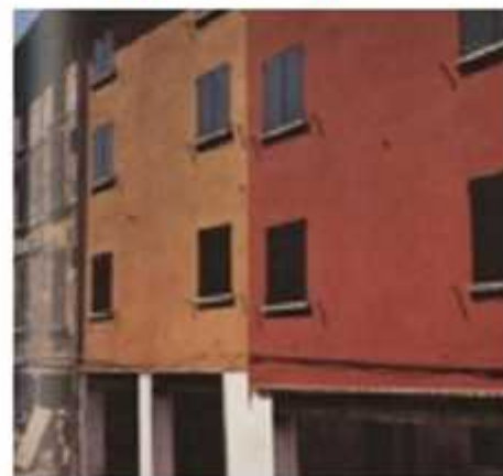
après la restauration :
