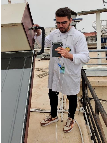
Figure III- 5: mesure de la température à l'entrée de la cuve de stockage
