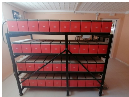
FIG. 2.61 : Pack batteries installées dans le batiment de commande.
