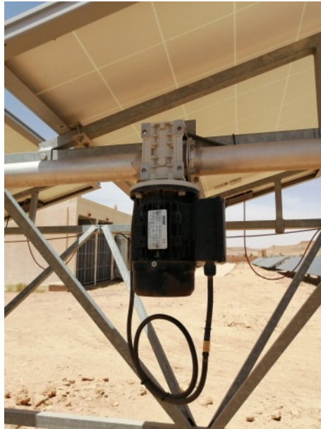
FIG. 2.36 : Le moteur électrique de la structure.
