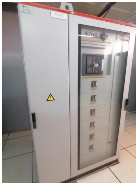
FIG. 2.39 : Tableau de parallèle TBT.
