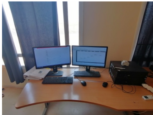
FIG. 2.70 : Les deux posts de supervision avec l'operateur SCADA.
