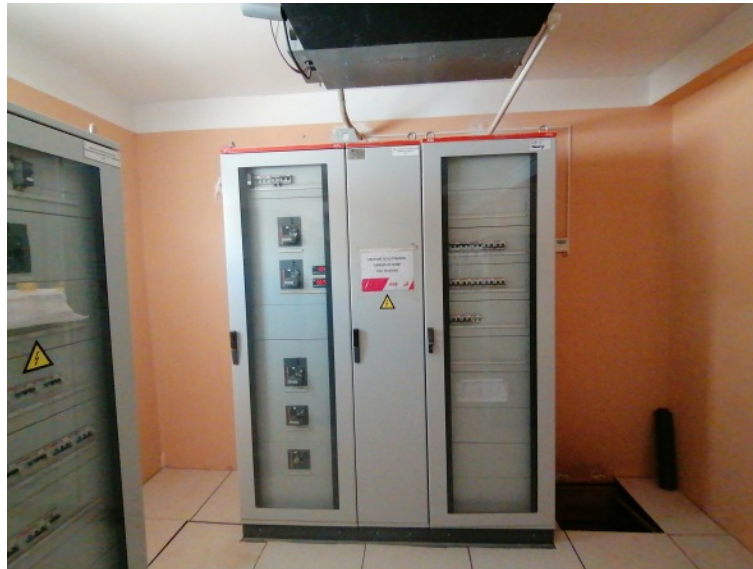
FIG. 2.62 : Tableau générale en courant continu.
