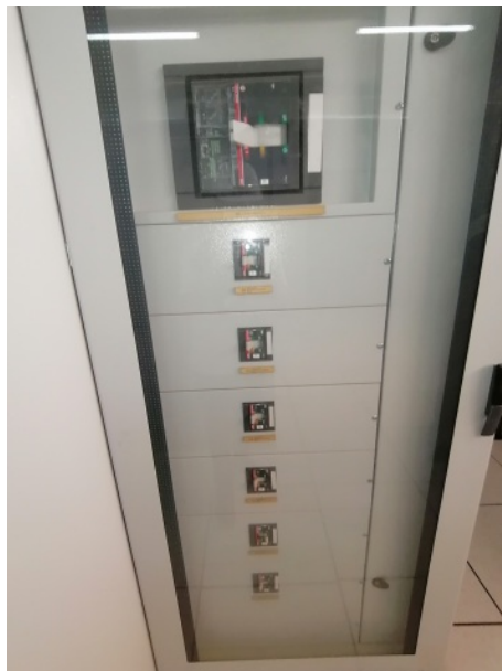
FIG. 2.41 : Disjoncteur a effet thermique et électromagnétique différentiel.
