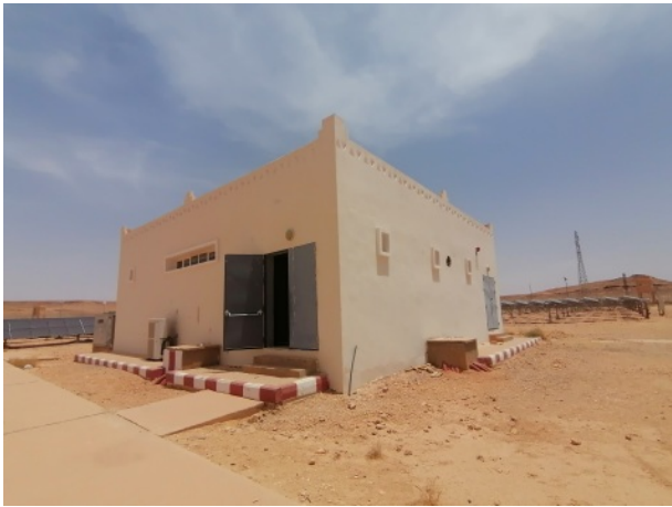
FIG. 2.43 : Bâtiment électrique vue de l'extérieur.
