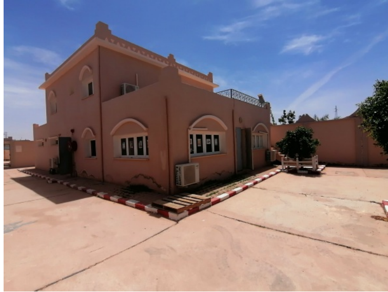
FIG. 2.65 : Vue extérieure du bâtiment de commande
