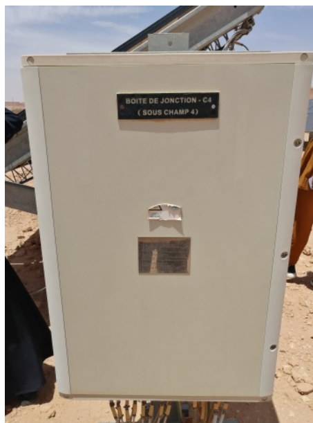
FIG. 2.23 : Boite de jonction n°4 du sous-champ 4
