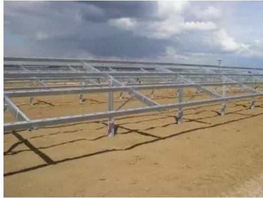
FIG. 2.3 : Exemple de structure fixe [25].
