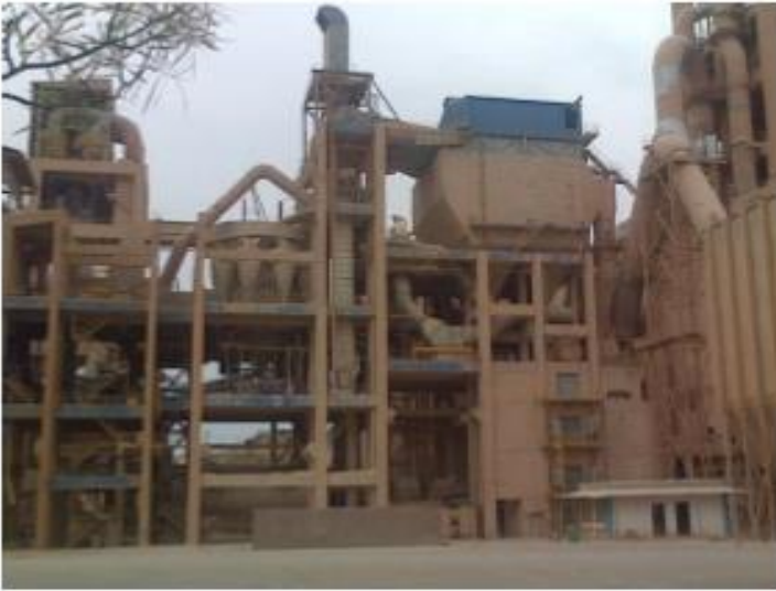
Figure I.24: Filtres à manches.
