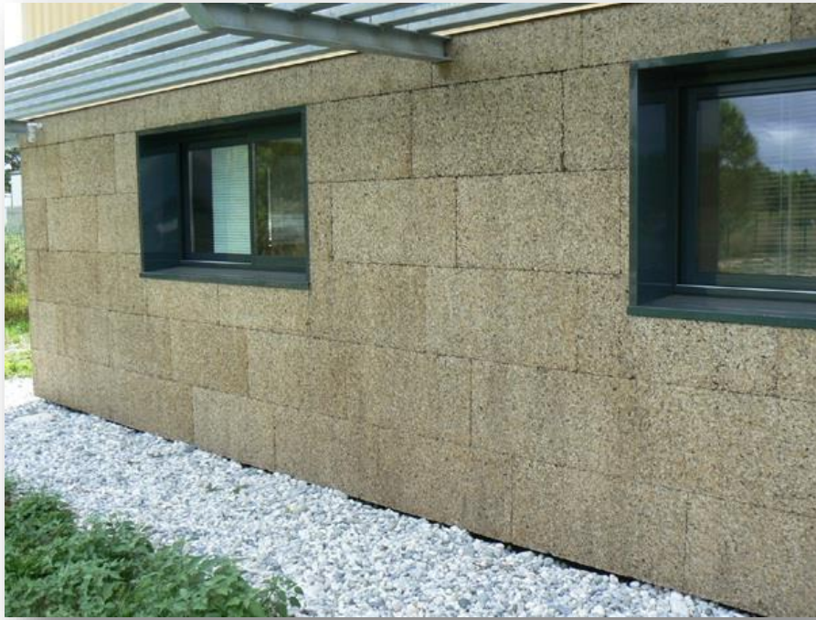
Figure 5.2 isolation extérieur avec le liège. (37)
