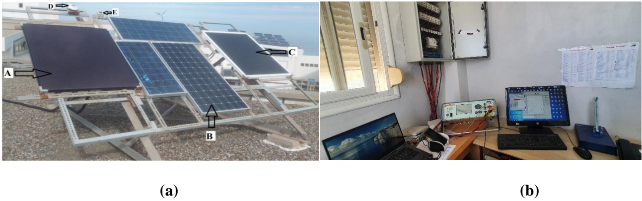
Figure II.01: Banc de caractérisation des modules PV en condition outdoor. (a), charge électronique et ordinateur pour l'acquisition des données (b) Banc de caractérisation des modules photovoltaïques à l'UDES.
