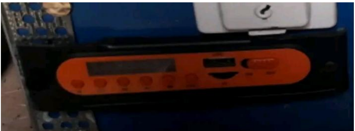
Figure (III-13) : Installation du plateau de radio.
