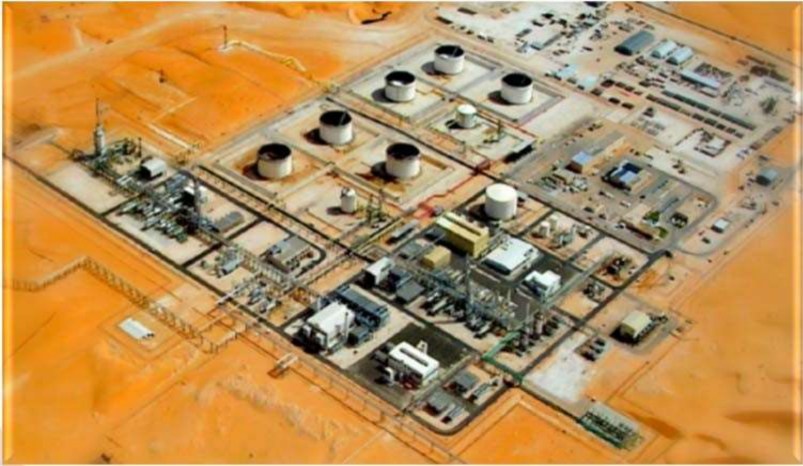
Figure 2.2 : centre de traitement des hydrocarbures BRN (CTH)
