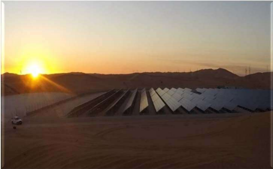
Figure 2.3 : centrale solaire BRN 10 MW
