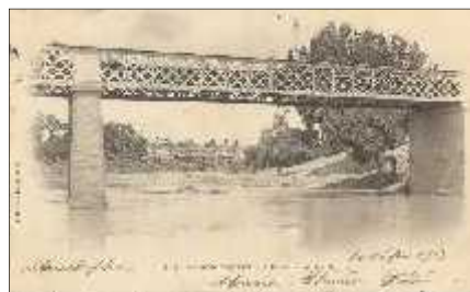
Figure 3.5 : Le pont en bois
