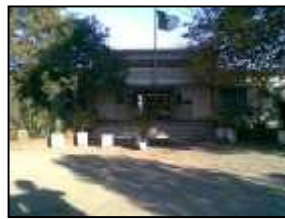
D : Entrée Sud
