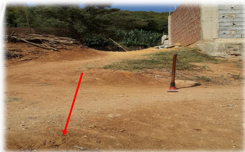
Photo III.5 : Le réseau d'assainissement.
