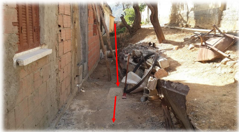
Photo III.3 : Le réseau d'assainissement.
