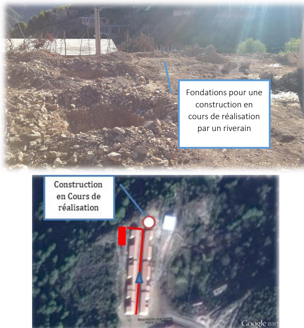
Photo III.1 : Position des constructions en cours de réalisation.
