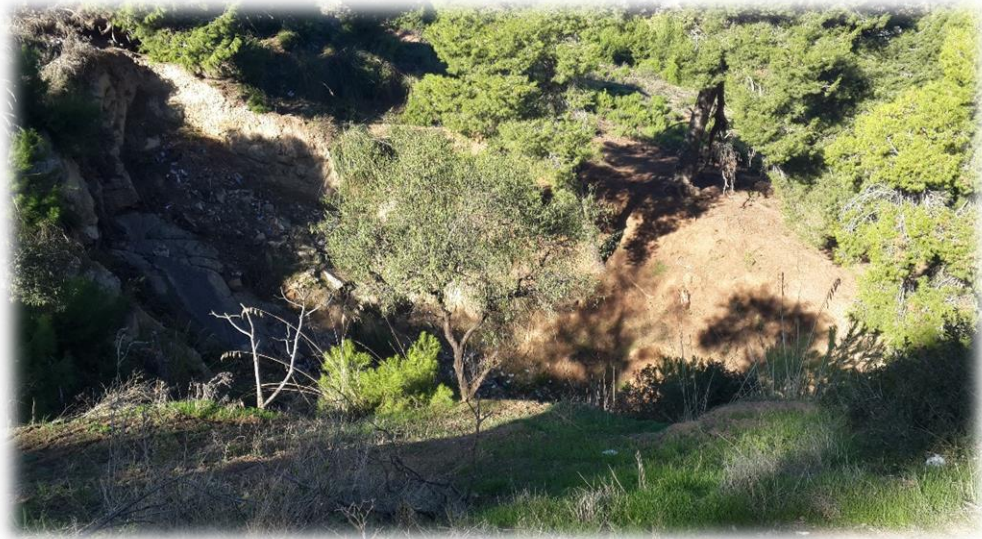
Photo III.4 : Un fossé crié par les eaux pluviales.
