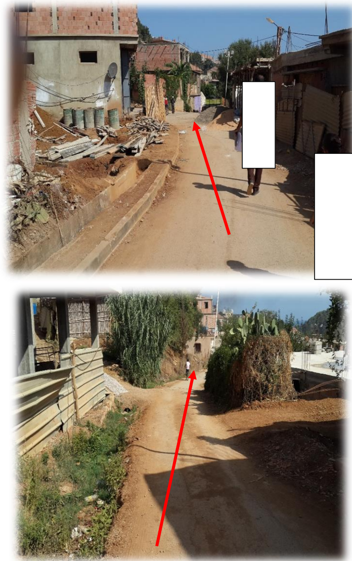
Photo III.1 : Un réseau d'assainissement existant.
