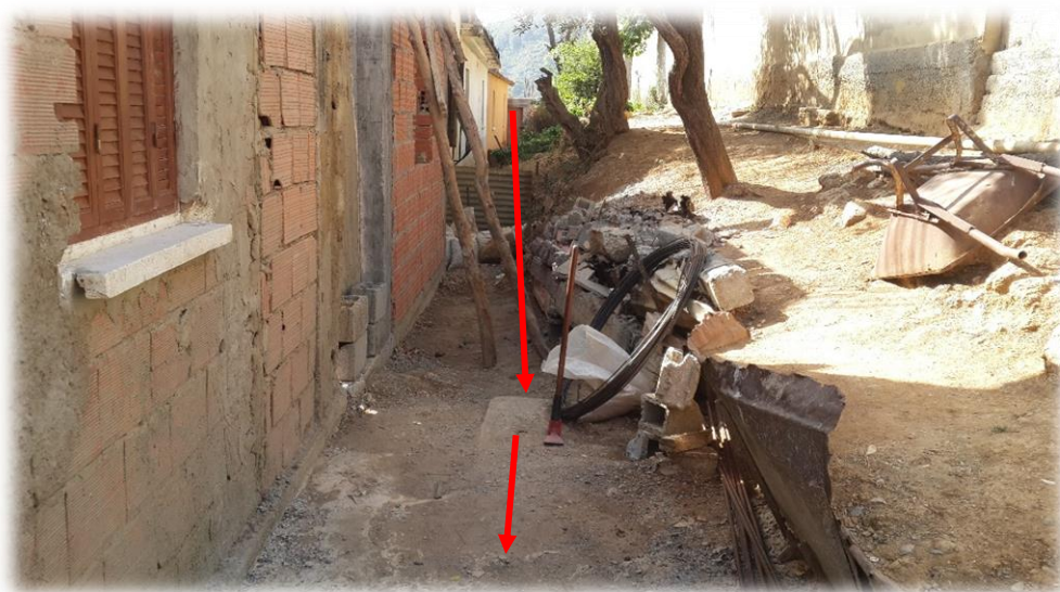
Photo III.3 : Le réseau d'assainissement.
