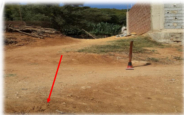
Photo III.5 : Le réseau d'assainissement.
