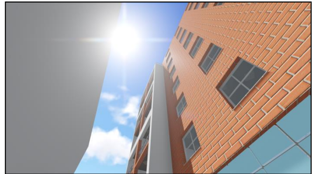
Fig 3.83 : Mur extérieur de l'ilot avec revêtement en brique
