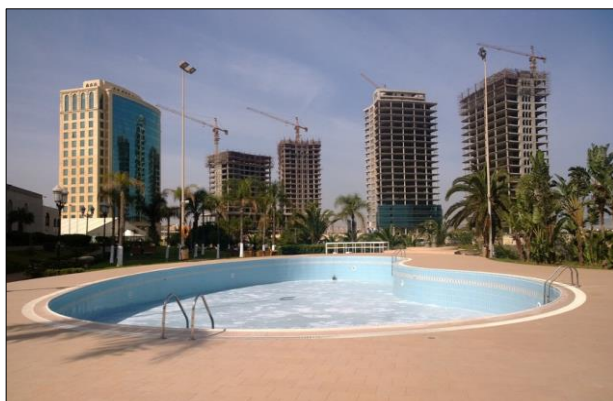
Figure 2.23 : Tours d'affaire en cours de réalisation Source : http://www.skvsranercity.com
