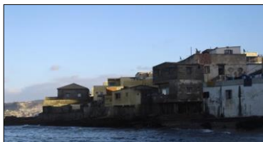
Fig 3.11 : Habitat du front de mer Srce : l' auteur 2015
