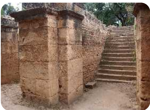
Figure ( 37) : photo de L'escalier d'accès et les piliers en arrière de l'édifice
