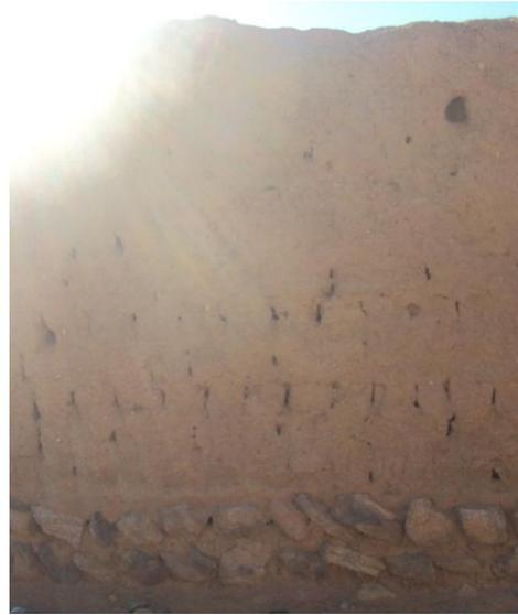
Fig. 72: face intérieure d'un mur montrant la fondation en pierre. Source: auteur.
