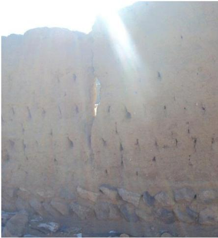
Fig. 61: face intérieur d'un mur montrant la fondation.
