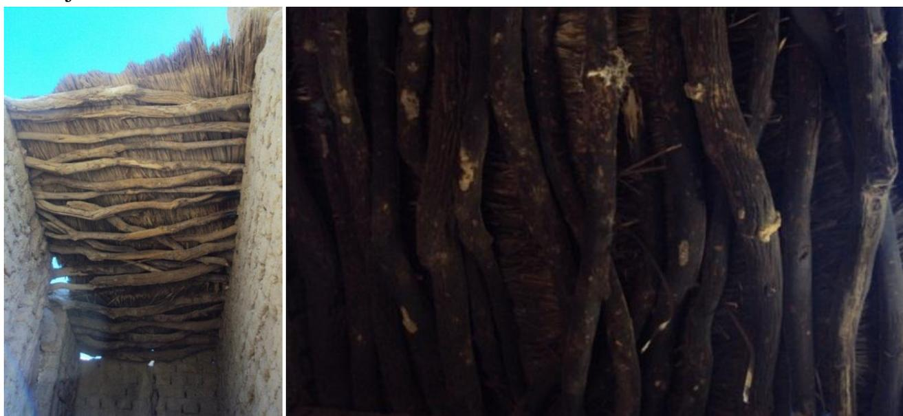
Fig. 93: restes de la couverture, plancher en tronc d'arbre.
