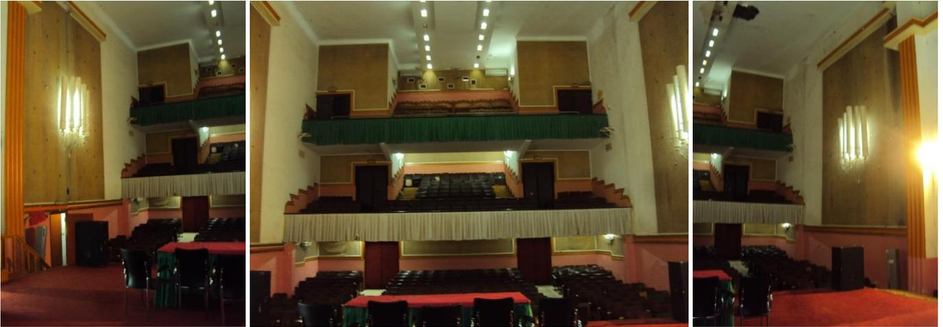
Le premier balcon : avec une pente de 8% abrite seulement des rangées de sièges (88 places) ; ces derniers sont disposés sur des gradins construits non démontables.
