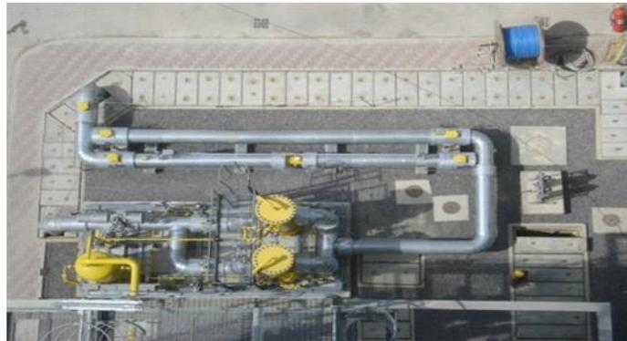
**Figure I.16 :** Détendeur de gaz.
