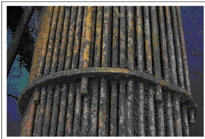
**Figure II.7 :** Exemple d'un faisceau de tubes d'un échangeur encrassé.
