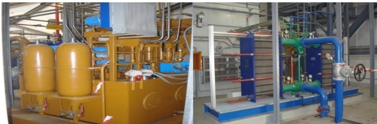
**Figure I.20 :** réservoir de l'huile hydraulique.
