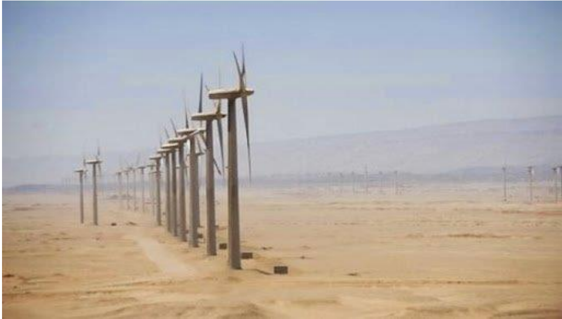
Figure 1.6 : Première ferme éolienne a axe horizontal en Algérie a adrar 2014 [32]
