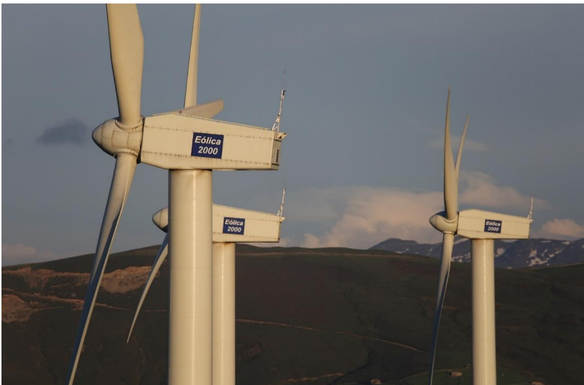
Figure 1.11 : Aérogénérateur GAMESA G52-850 KW
