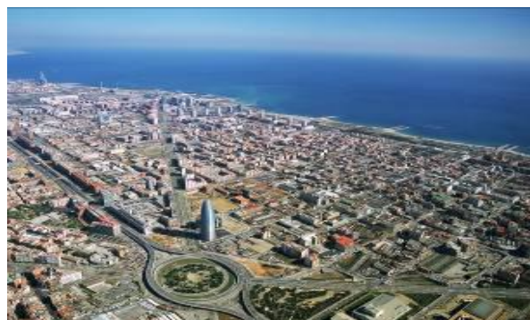
Photos 04. La partie réalisée du projet @22.
