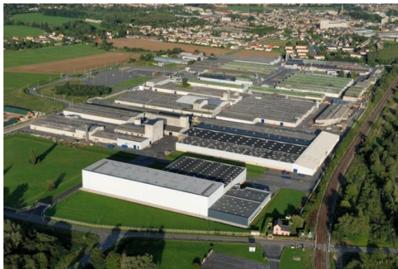
Photos 01. La zone industrielle de Glairé. France.
