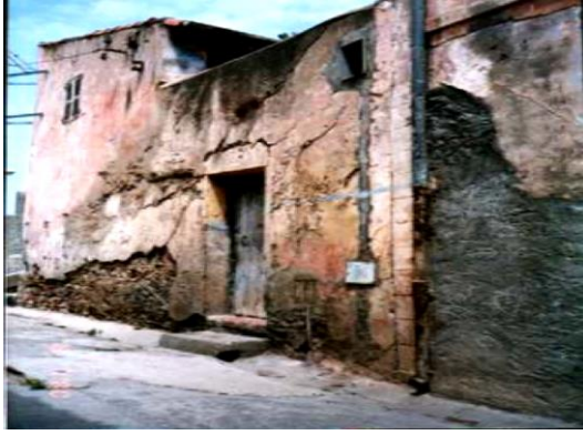
Photos 15. Façade d'une maison.
