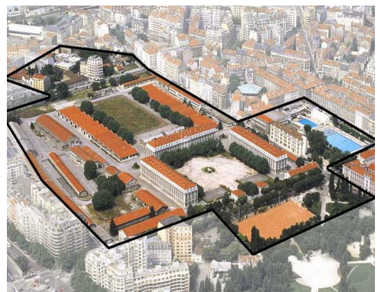
la caserne avant l'intervention
