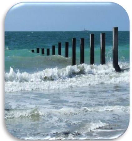
Fig.3. Les ouvrages transversaux aux épis
