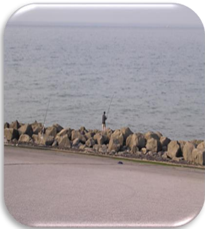
Fig.1. Les ouvrages longitudinaux des Haute plage (Digues , Murs)
