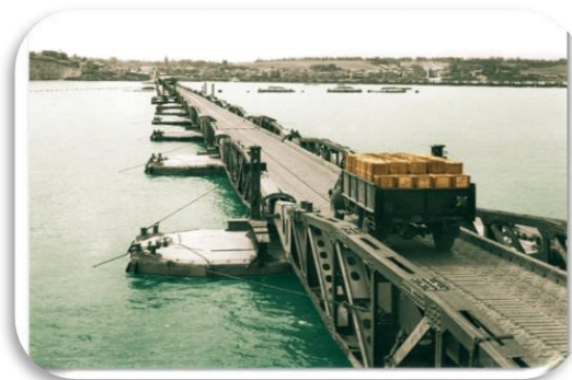
Fig.3. Port artificiels de Arromanches (France)
