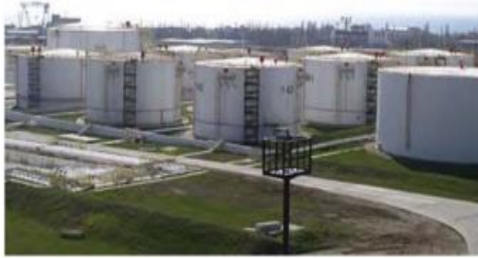
Figure I-5 : Photo numérique d'un ensemble des bacs à toit fixe
