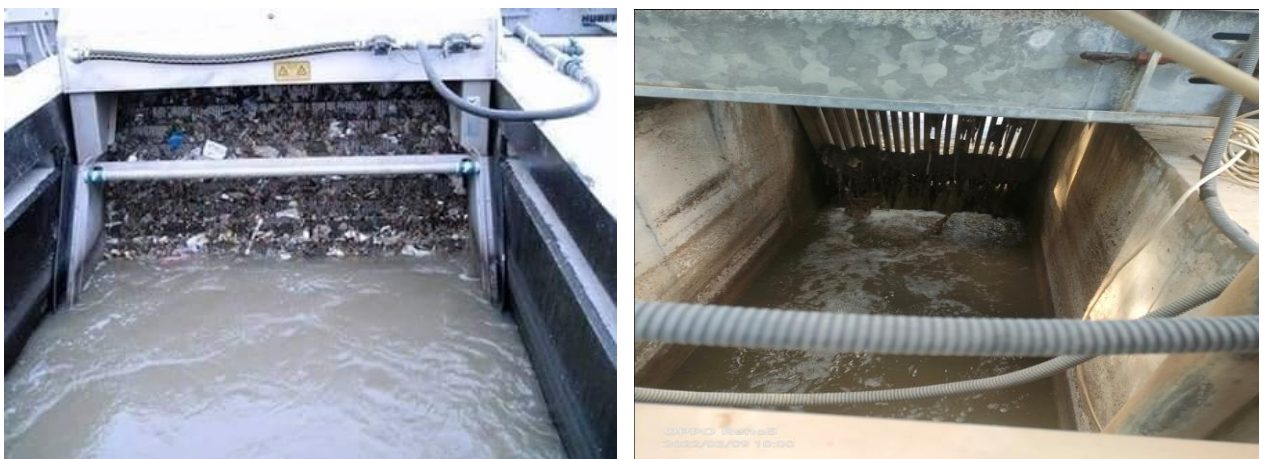
Figure1.1 :Dégrilleur.
