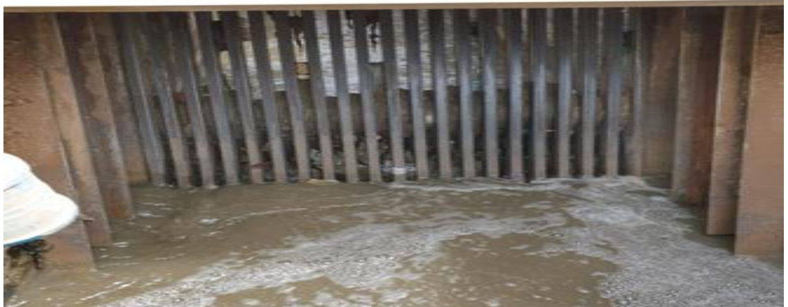
Figure 2.6 : Dégrilleur fin.
