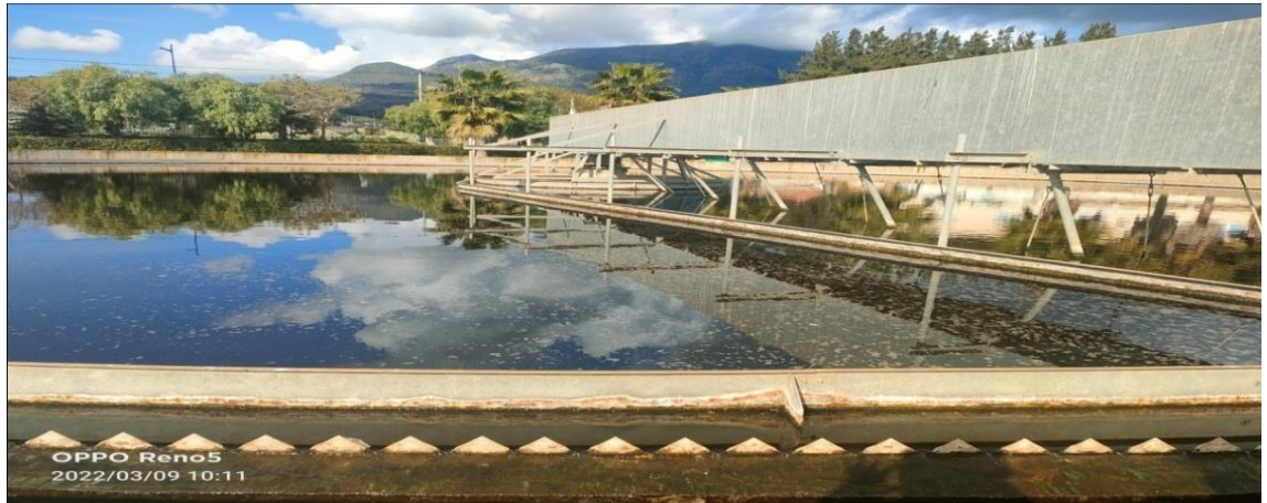
Figure1.3 : Décanteur
