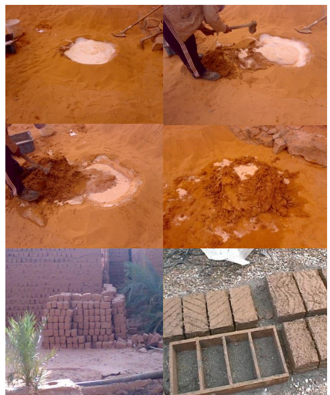
Fig. 3.66: les étapes de préparation de la terre
