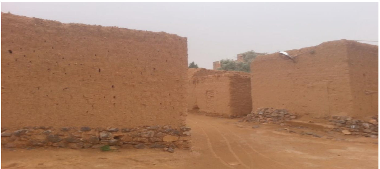
Fig. 3.85: Photo de Mur Mixte
