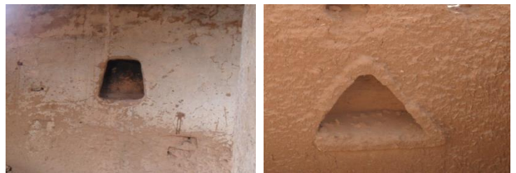
Fig. 3.95: photos des niches
