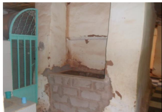
Fig. 3.25: Le puits de Mosquée
