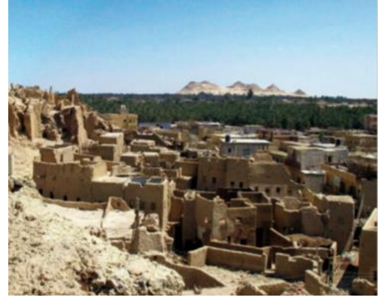
Fig.2.5: vue générale de l'ancien Shali de Siwa
