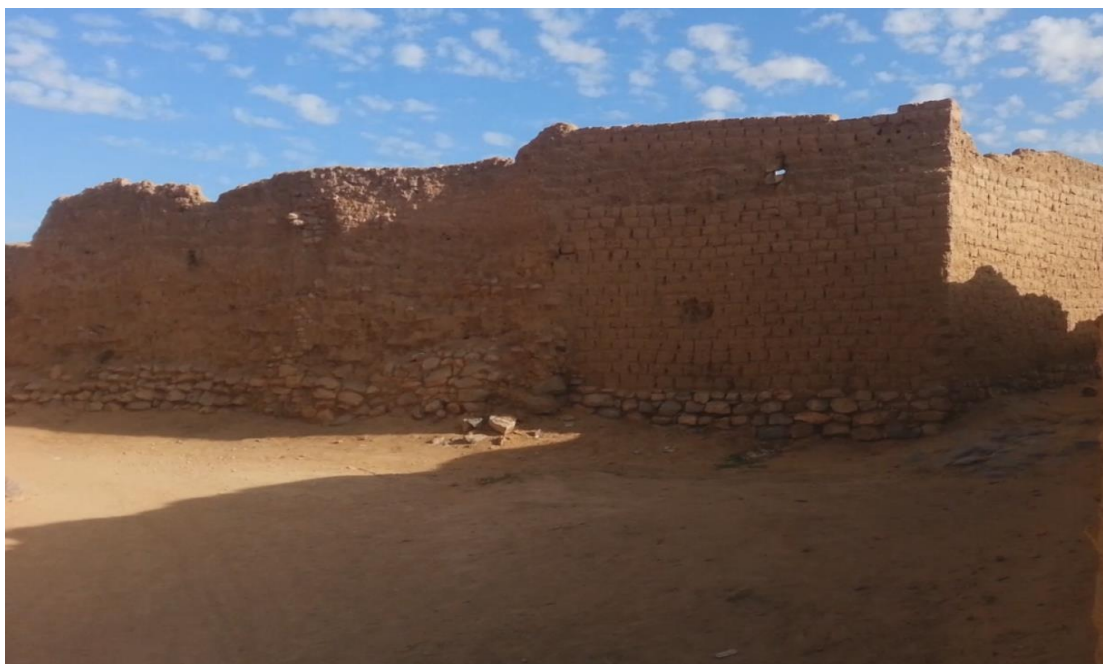
Fig. 3.92: Photo de mur avec fondation en pierre
