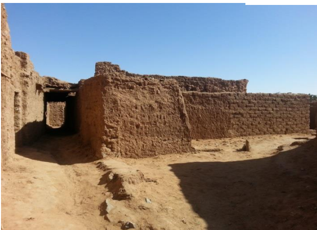
Fig. 3.43 : Photo panoramique de la maison Bouziane
