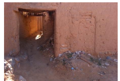
Fig. 3.29: voie tertiaire « Derieb »
