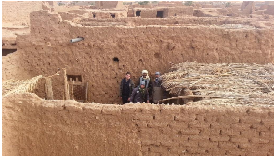
Fig. 3.42 : Photo panoramique de la maison Bouziane
