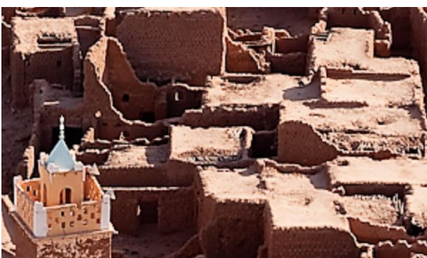
Fig. 3.54: photo d'ensemble du groupement zaouia
