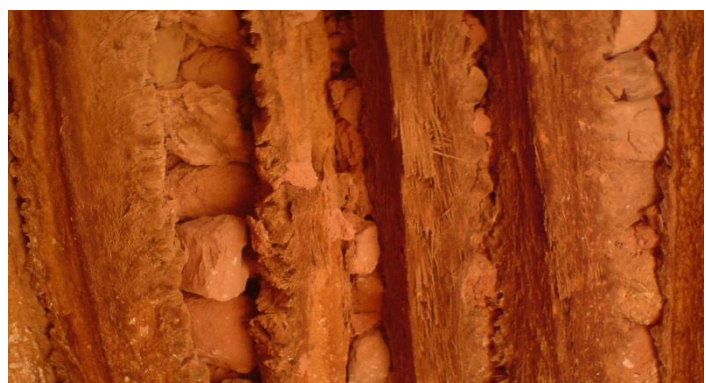
Fig. 3.81: Photo de plancher à Tafsa
