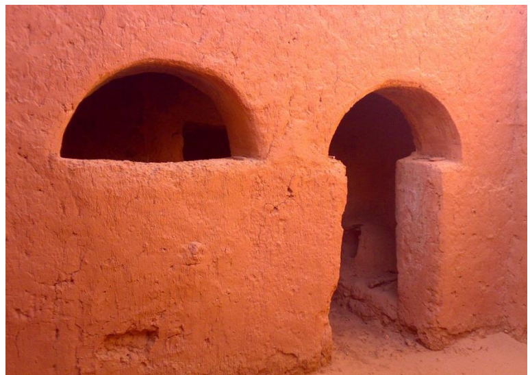
Fig. 3.87: Porte Arcade en Adobe
