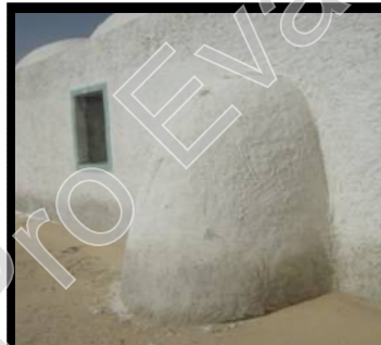
Figure1.4: les types des contreforts
