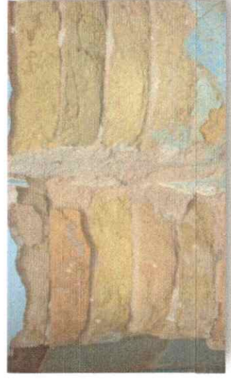
Fig. 13 : mur porteur en brique crue (adobe) La source : l'auteur
