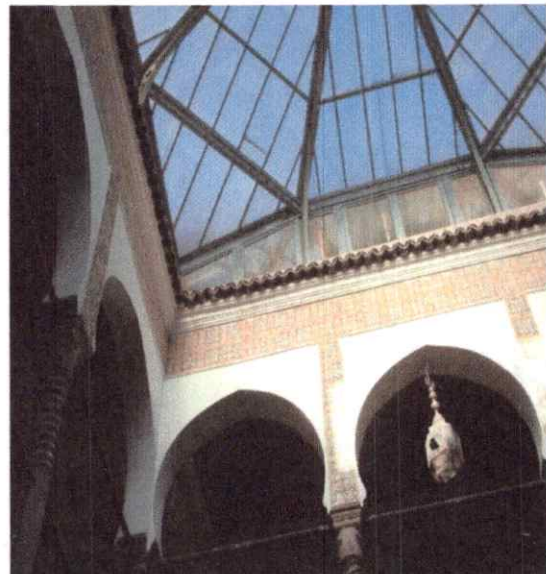
Photo de maison chebek: source Magazine « vies des villes »
