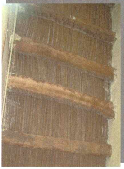
Fig. 11 : les poutres de plancher (solive en bois) Source : l'auteur
