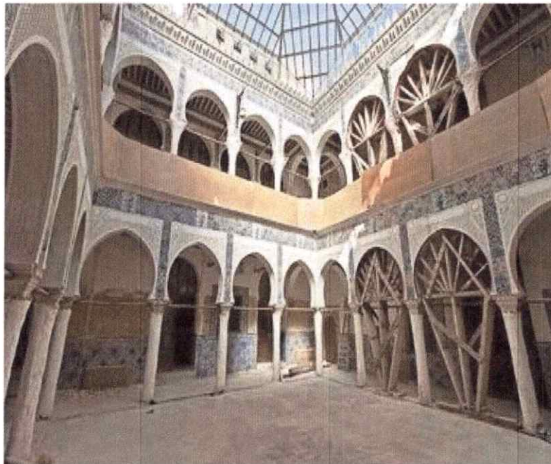
Photo de maison chebek source magazine « vies des villes »
